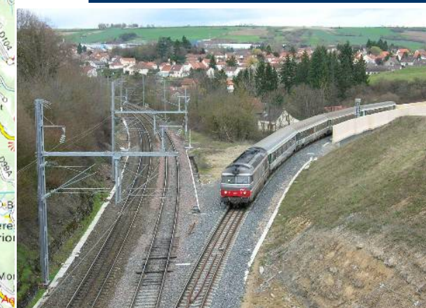
Zone de raccordements ferroviaires
