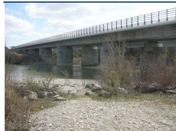
Viaduc de la LGV Paris - Marseille sur le canal de Miribel
