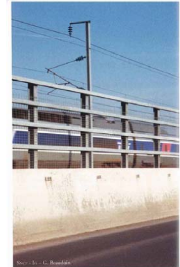
Exemple de dispositif antipénétration
