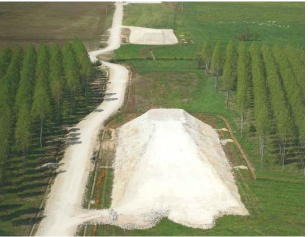
➡ Zone de préchargement sur la LGV Rhin-Rhône (Source : RFF)
