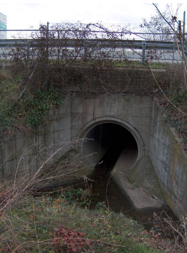
➡ Buse béton avec murs en ailes
